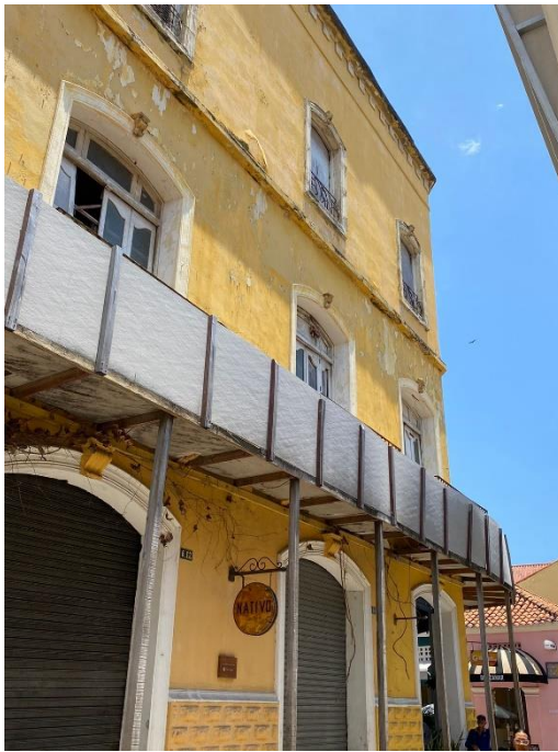
Imagen 3 – Fachada del inmueble.
