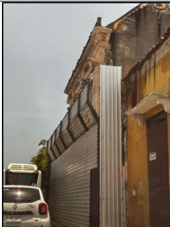
Figura 3 – Cerramiento ejecutado
