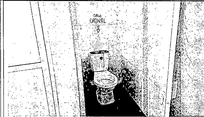
5. Baterías de baño (deterioradas)
